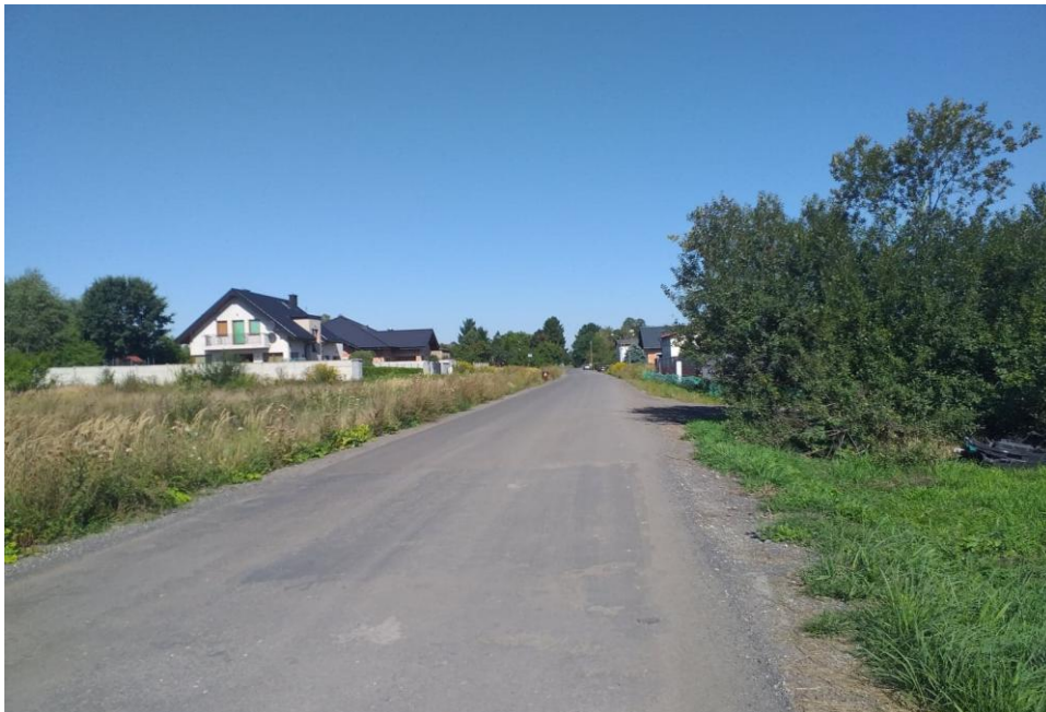
Konieczny do przebudowania odcinek ulicy Polnej. Materiały MZDiT
