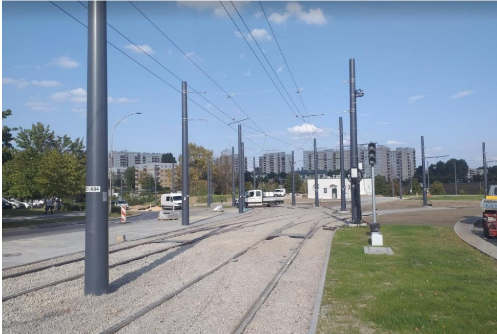
Rozjazd przed pętlą tramwajową przy ulicy Fieldorfa „Nila” w trakcie przebudowy torowiska. Materiały MZDiT
