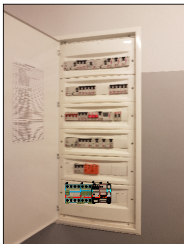
Istn. tablica TR przeznaczona do rozbudowy
