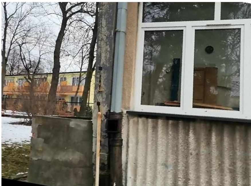
Fot. 3 –liczne spękania oraz rury spustowe nie nadające się do użytku
