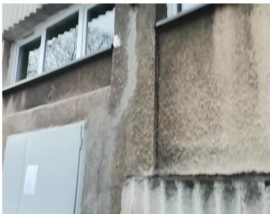
Fot. 6 – liczne spękania na elewacji
