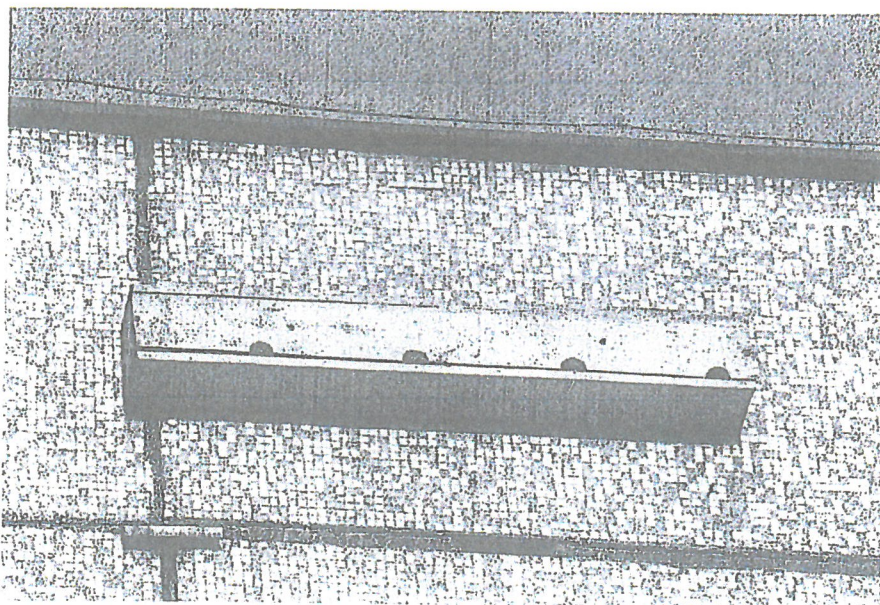
Sposób umieszczenia budki przed ociepleniem bloku; zdjęcie wykonane na jednym z bloków w Jaworznie, podawane jako przykład (aut. Szymon Wójcik)
