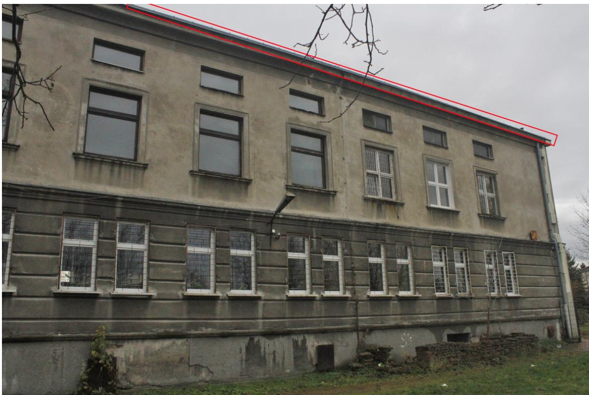
Fot. 7. Częstochowa, ul. Warszawska 142 - segment B fragment elewacji północnej. Kolorem czerwonym oznaczono obszar szczelin pod obróbką blacharską dachu dogodnych jako miejsca lęgowe dla jerzyków Apus apus (fot. budynku z dn. 04.11.2021 – S. Czyż)
