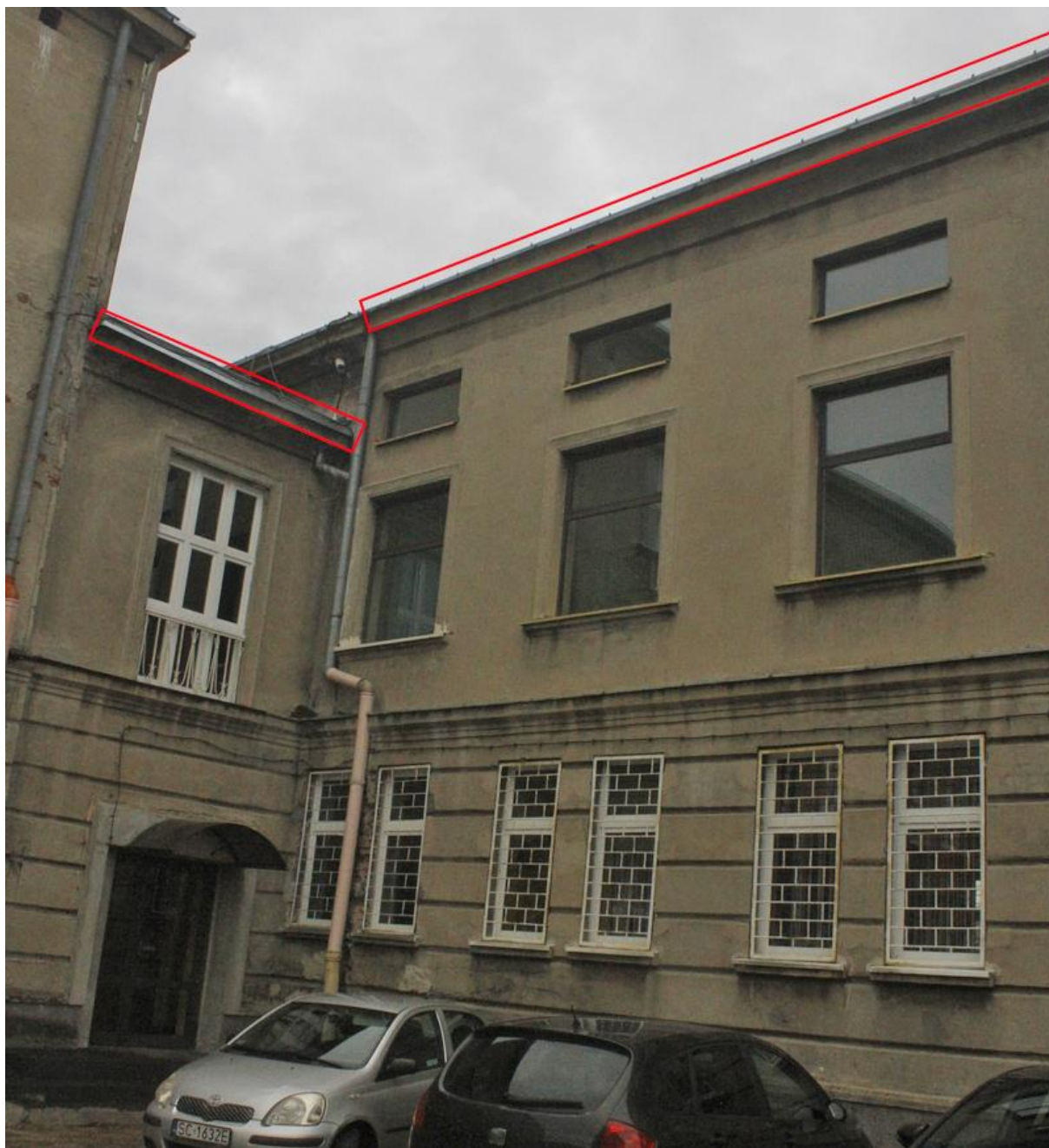
Fot. 4. Częstochowa, ul. Warszawska 142 - segment A fragment elewacji wschodniej oraz fragment elewacji południowej segmentu B. Kolorem czerwonym oznaczono obszar szczelin pod obróbką blacharską dachu dogodnych jako miejsca lęgowe dla jerzyków Apus apus (fot. budynku z dn. 04.11.2021 – S. Czyż)
