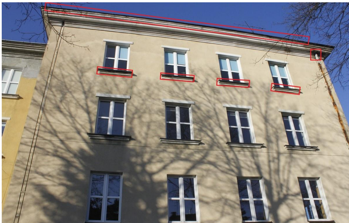
Fot. 34. Częstochowa ul. Jasnogórska 84/90 – segment F – elewacja wschodnia. Podczas oględzin budynku stwierdzono szczeliny przy spuszczeniu rynnowym, pod parapetami okiennymi oraz pod obróbką blacharską na całej jej długości (oznaczone na fotografii kolorem czerwonym) będące dogodnymi miejscami lęgowymi dla ptaków z gatunków chronionych, jak jerzyk Apus apus czy wróbel Passer domesticus (fot. S. Czyż – 23.02.2022).
