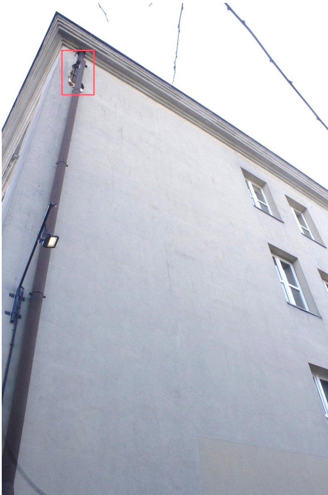
Fot. 38. Częstochowa ul. Jasnogórska 84/90 – segment F – część elewacji zachodniej. W trakcie oględzin stwierdzono dużą szczelinę za spustem rynnowym. Z uwagi na jej rozmiar jest to potencjalne miejsce lęgowe kawki Corvus monedula – gatunku chronionego (fot. S. Czyż – 23.02.2022)
