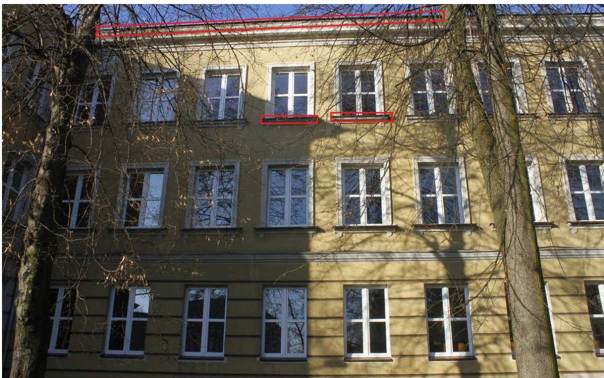
Fot. 9. Częstochowa ul. Jasnogórska 84/90 – segment B – fragment elewacji wschodniej. W trakcie oględzin stwierdzono szereg szczelin istniejących pod obróbką blacharską oraz pod parapetami okiennymi (oznaczone na fotografii kolorem czerwonym) będących dogodnymi miejscami lęgowymi dla ptaków z gatunków chronionych, jak jerzyk Apus apus czy wróbel Passer domesticus (fot. S. Czyż – 23.02.2022)
