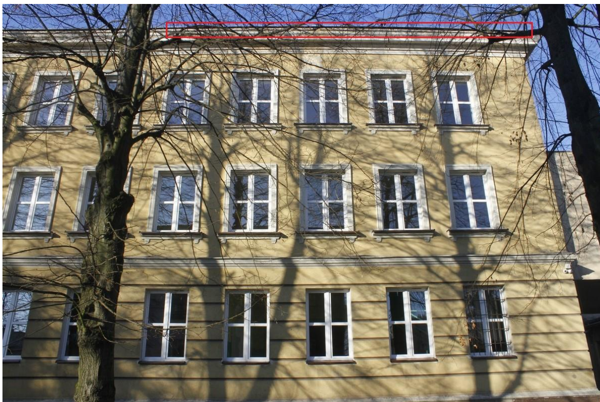
Fot. 12. Częstochowa ul. Jasnogórska 84/90 – segment B – fragment elewacji wschodniej c.d. W trakcie oględzin stwierdzono szereg szczelin istniejących pod obróbką blacharską (oznaczone na fotografii kolorem czerwonym) będących dogodnymi miejscami lęgowymi dla ptaków z gatunków chronionych, jak jerzyk Apus apus czy wróbel Passer domesticus (fot. S. Czyż – 23.02.2022)
