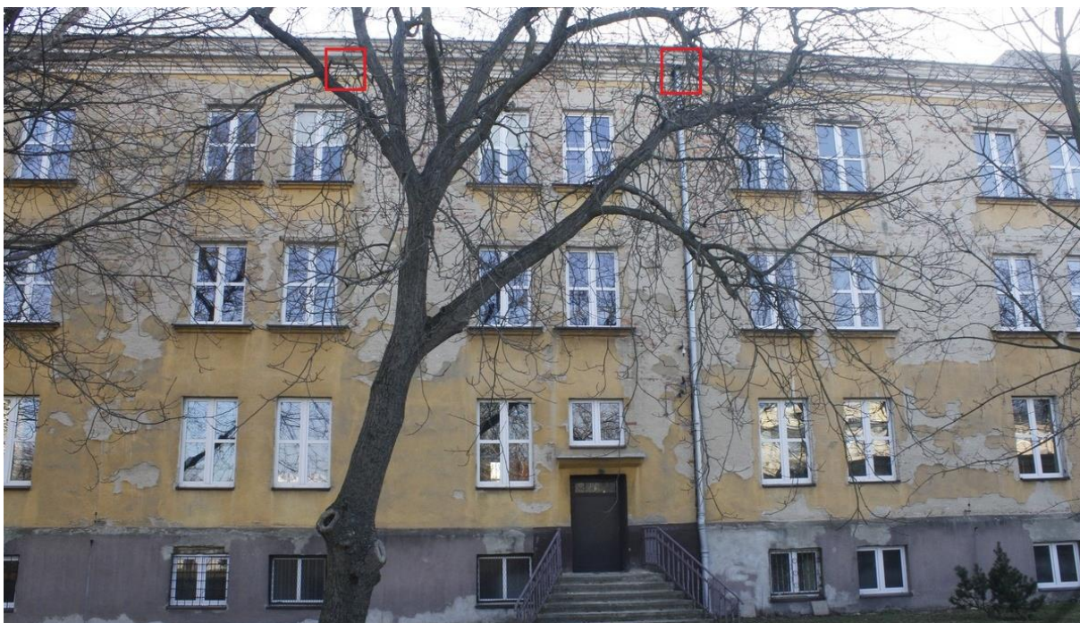
Fot. 27. Częstochowa ul. Jasnogórska 84/90 – segment E – elewacja zachodnia c.d. W trakcie oględzin stwierdzono szczeliny przy spuście rynnowym (oznaczone na fotografii kolorem czerwonym) będące potencjalnymi miejscami lęgowymi dla ptaków z gatunków chronionych, jak jerzyk Apus apus czy wróbel Passer domesticus . Ponadto między oknami ostatniej kondygnacji istnieje duży otwór w ścianie (oznaczony kolorem czerwonym na fotografii) będący odpowiednim, z uwagi na jego wielkość, miejscem lęgowym dla kawki Corvus monedula – też gatunek chroniony (fot. S. Czyż – 23.02.2022)
