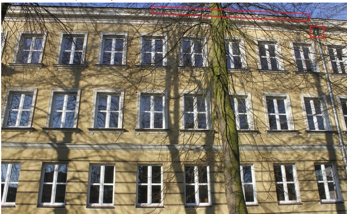
Fot. 10. Częstochowa ul. Jasnogórska 84/90 – segment B – fragment elewacji wschodniej c.d. W trakcie oględzin stwierdzono szereg szczelin istniejących pod obróbką blacharską oraz przy spuście rynnowym (oznaczone na fotografii kolorem czerwonym) będących dogodnymi miejscami lęgowymi dla ptaków z gatunków chronionych, jak jerzyk Apus apus czy wróbel Passer domesticus (fot. S. Czyż – 23.02.2022)
