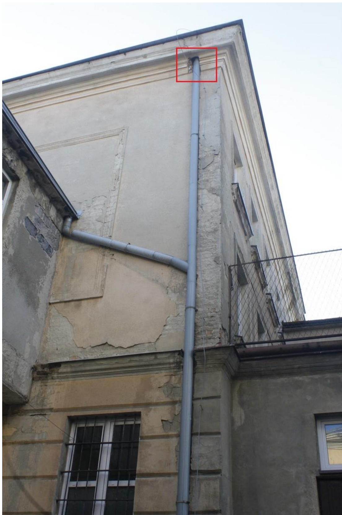
Fot. 15. Częstochowa ul. Jasnogórska 84/90 – segment B – fragment elewacji północnej. W trakcie oględzin stwierdzono szczeliny przy spuszczeniu rynnowym (oznaczone na fotografii kolorem czerwonym) będące dogodnymi miejscami lęgowymi dla ptaków z gatunków chronionych, jak jerzyk Apus apus czy wróbel Passer domesticus (fot. S. Czyż – 23.02.2022).
