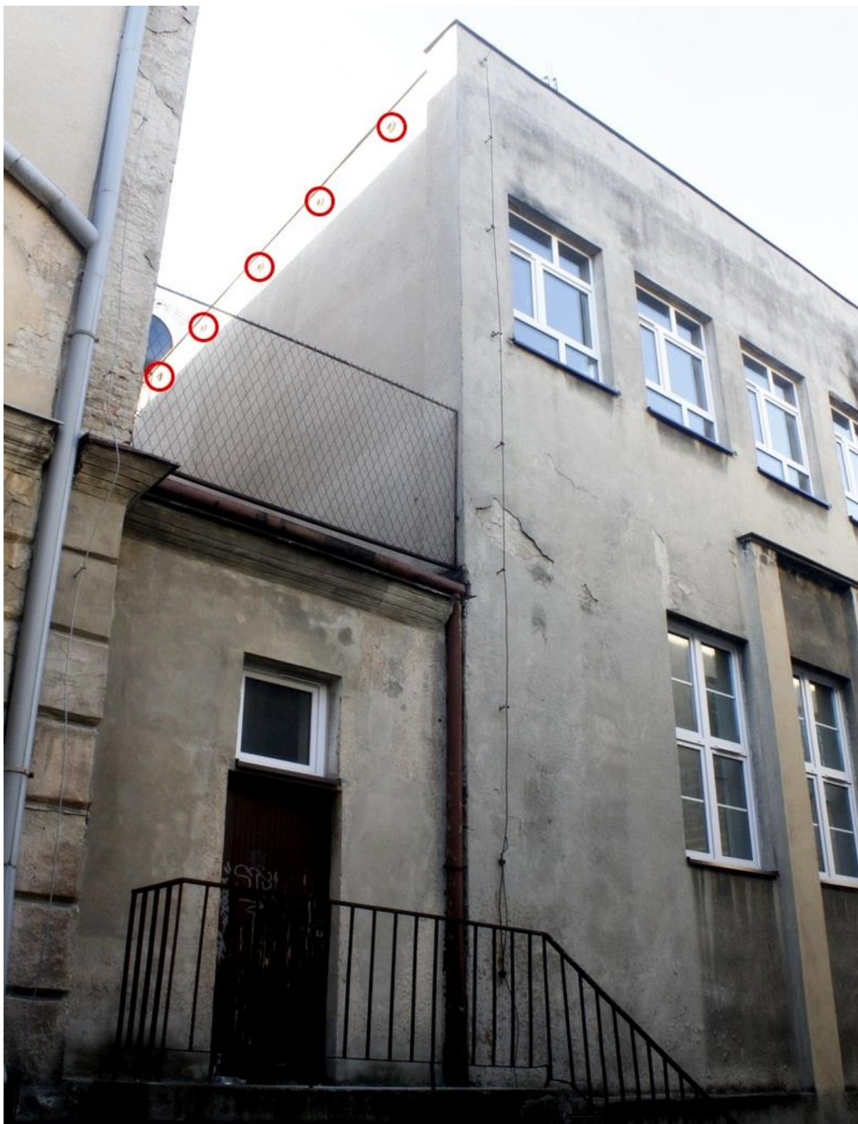
Fot. 17. Częstochowa ul. Jasnogórska 84/90 – segment C – elewacja wschodnia i fragment północnej. W trakcie oględzin na elewacji wschodniej stwierdzono drożne otwory wentylacyjne w liczbie 6 (jeden z otworów niewidoczny na fotografii) prowadzące do stropodachu. Duża średnica tych otworów powoduje, że należy te miejsca traktować jako potencjalne miejsca lęgowe kawek Corvus monedula - gatunku chronionego (fot. S. Czyż – 23.02.2022)
