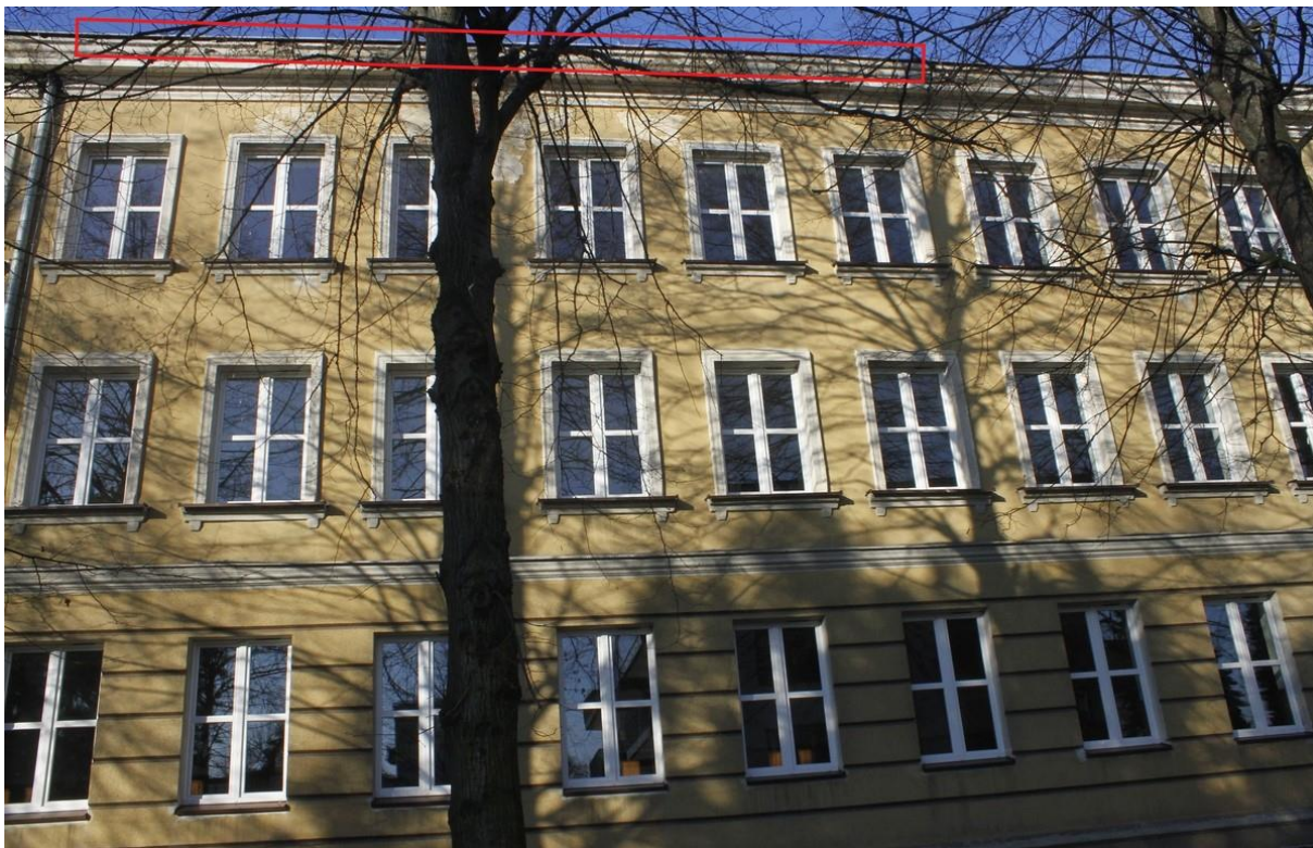
Fot. 11. Częstochowa ul. Jasnogórska 84/90 – segment B – fragment elewacji wschodniej c.d. W trakcie oględzin stwierdzono szereg szczelin istniejących pod obróbką blacharską (oznaczone na fotografii kolorem czerwonym) będących dogodnymi miejscami lęgowymi dla ptaków z gatunków chronionych, jak jerzyk Apus apus czy wróbel Passer domesticus (fot. S. Czyż – 23.02.2022)
