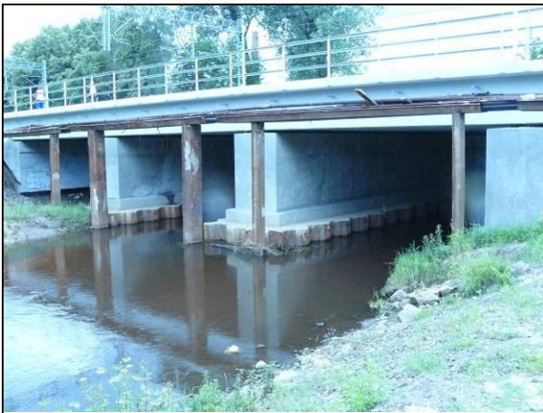
Rejon ul. Twardej - prześwit mostu kolejowego na rzece Stradomka
