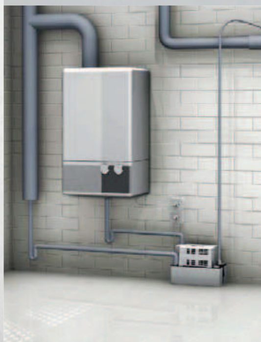
Odprowadzanie kondensatu z wiszącego kotła gazowego
