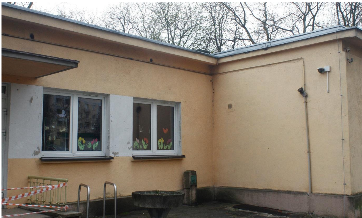
Fot. 5. Częstochowa, ul. Gwiazdna 2, budynek Miejskiego Przedszkola nr 13 – fragment elewacji północnej oraz elewacja wschodnia segmentu A. Widoczne otwory wentylacyjne do stropodachu - zabezpieczone (fot. z dn. 15.04.2022 - S. Czyż)
