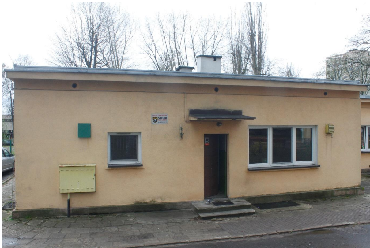
Fot. 2. Częstochowa, ul. Gwiazdna 2, budynek Miejskiego Przedszkola nr 13 – fragment elewacji północnej segmentu A. Widoczne otwory wentylacyjne do stropodachu - zabezpieczone (fot. z dn. 15.04.2022 - S. Czyż)
