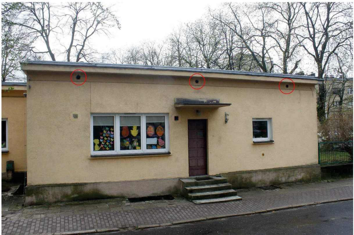
Fot. 6. Częstochowa, ul. Gwiazdna 2, budynek Miejskiego Przedszkola nr 13 – fragment elewacji północnej segmentu A. Widoczne niezabezpieczone otwory wentylacyjne do stropodachu. Przy dwóch z nich obserwowano kawki Corvus monedula (fot. z dn. 15.04.2022 - S. Czyż)
