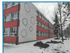
Termomodernizacja Szkoły Podstawowej nr 36 w Częstochowie
