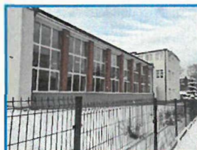
Termomodernizacja Zespołu Szkolno-Przedszkolnego nr 3 w Częstochowie
