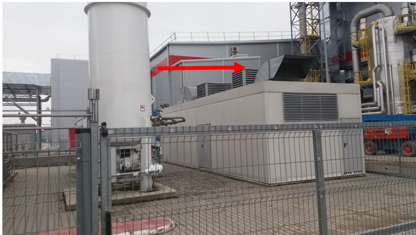
Rysunek 18. Przykład kierunkowania źródła hałasu (wyrzutnia powietrza zaznaczona strzałką).
