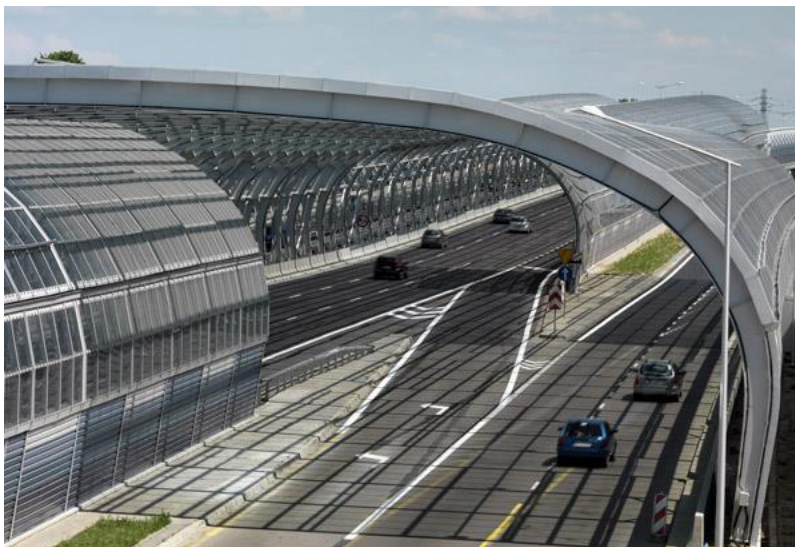
Rysunek 6. Przykład ekranu akustycznego póttunelowego.
