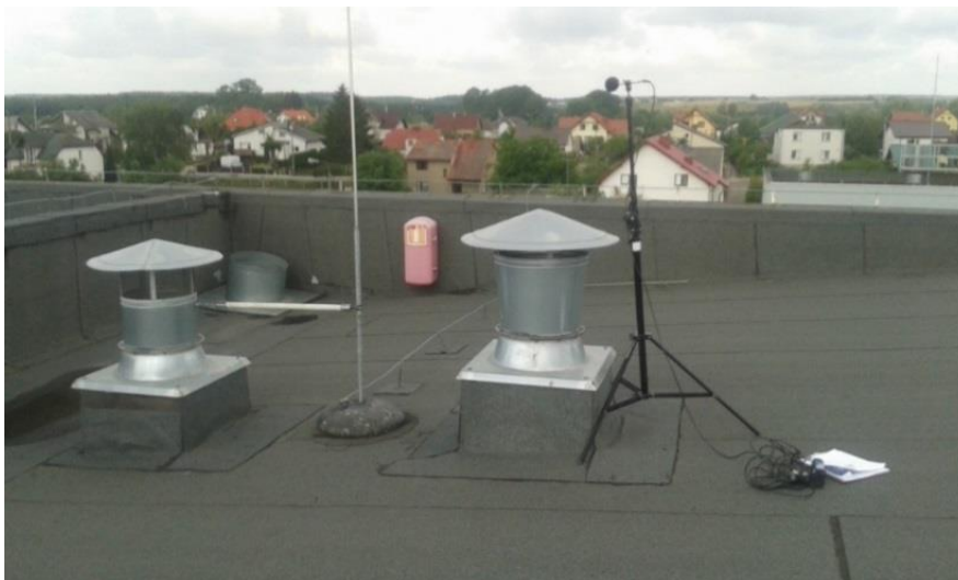
Rysunek 19. Przykład przegrody rozbijającej falę akustyczną.
