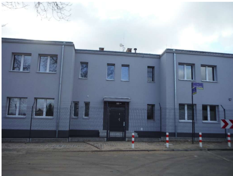
Zdjęcie 1 Badany obiekt
