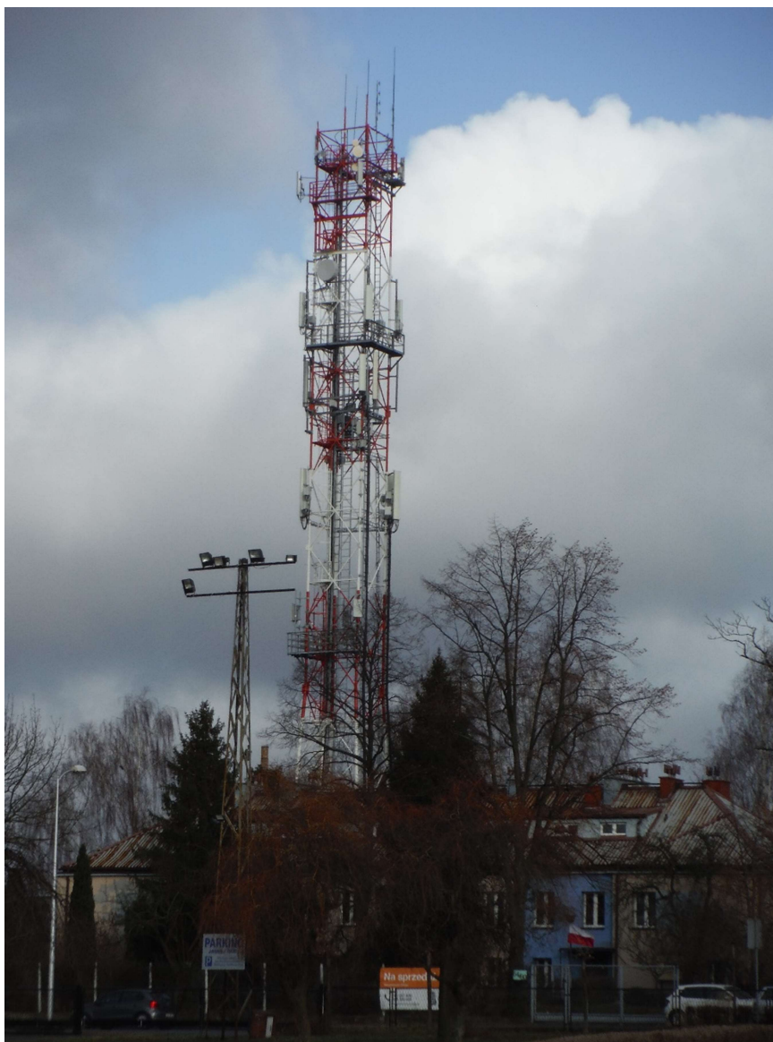
Zdjęcie 1 Badany obiekt
