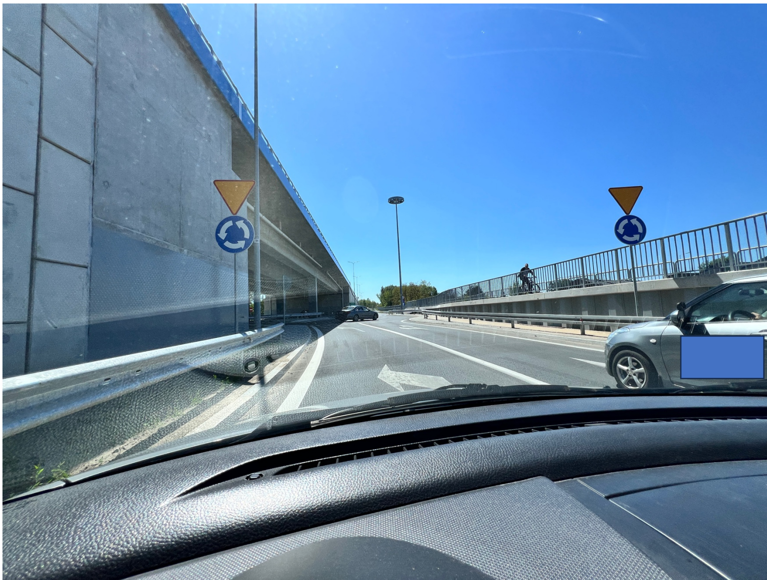
Dojazd do ronda DK91 od strony Al. JP11 - ograniczenie widoczności przez nasyp wiaduktu.
