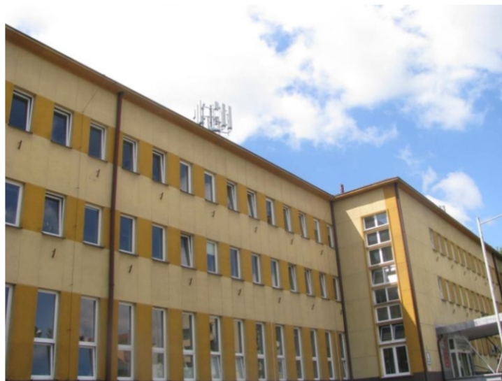
Zał. nr 1: Widok ogólny instalacji radiokomunikacyjnej.
