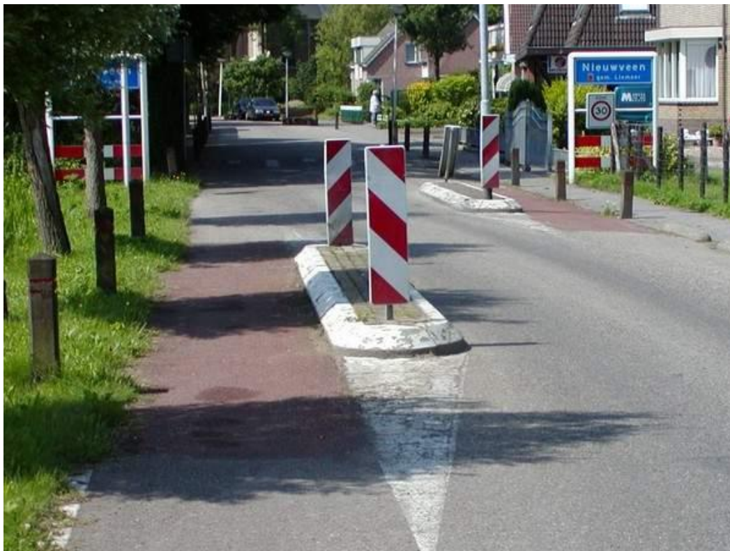
Rysunek 6-5 Mijanka zmuszająca do zwolnienia, a często do przepuszczenia pojazdu z naprzeciwka
