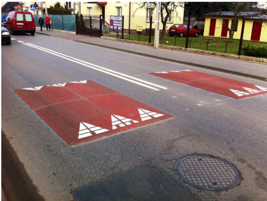
Rysunek 6-6 Przeszkody poprzeczne - nieszkodliwe dla autobusów, zmuszające do zwolnienia samochodu osobowe
