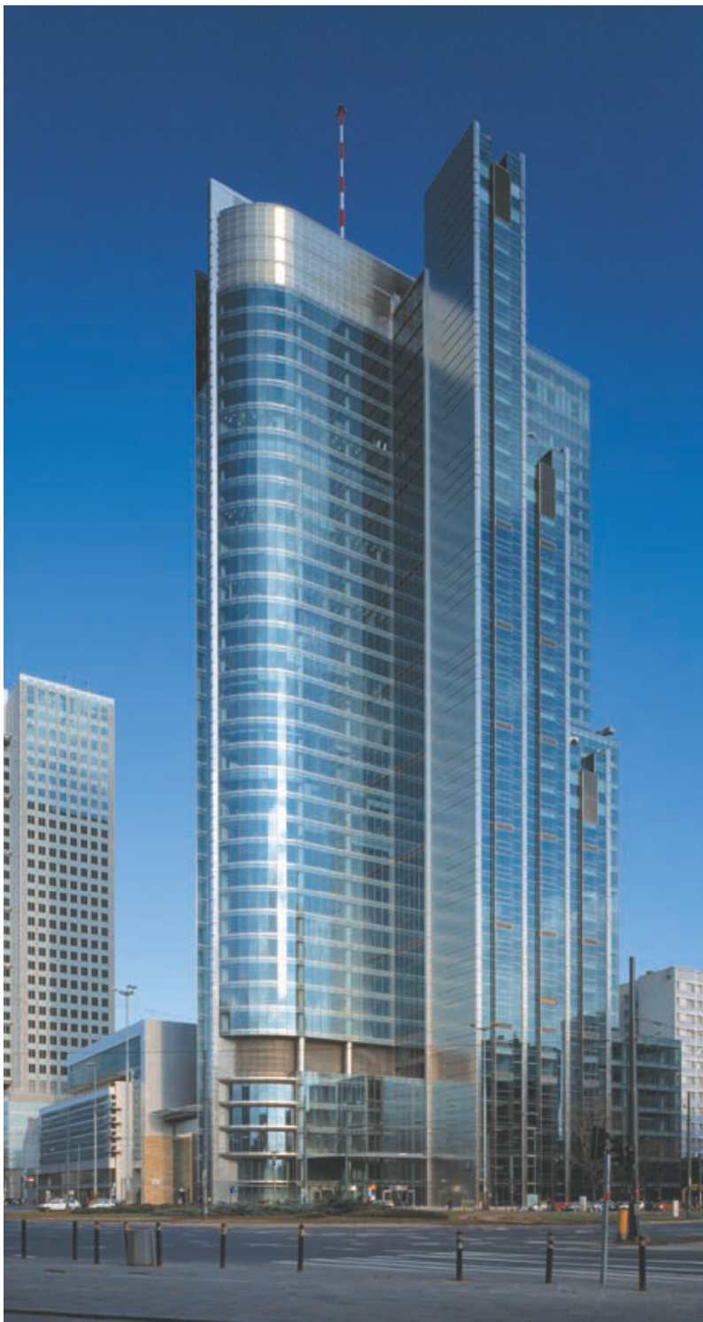
Budynek: Rondo 1 Miało: Warszawa Deweloper: Hochtief Development Poland
