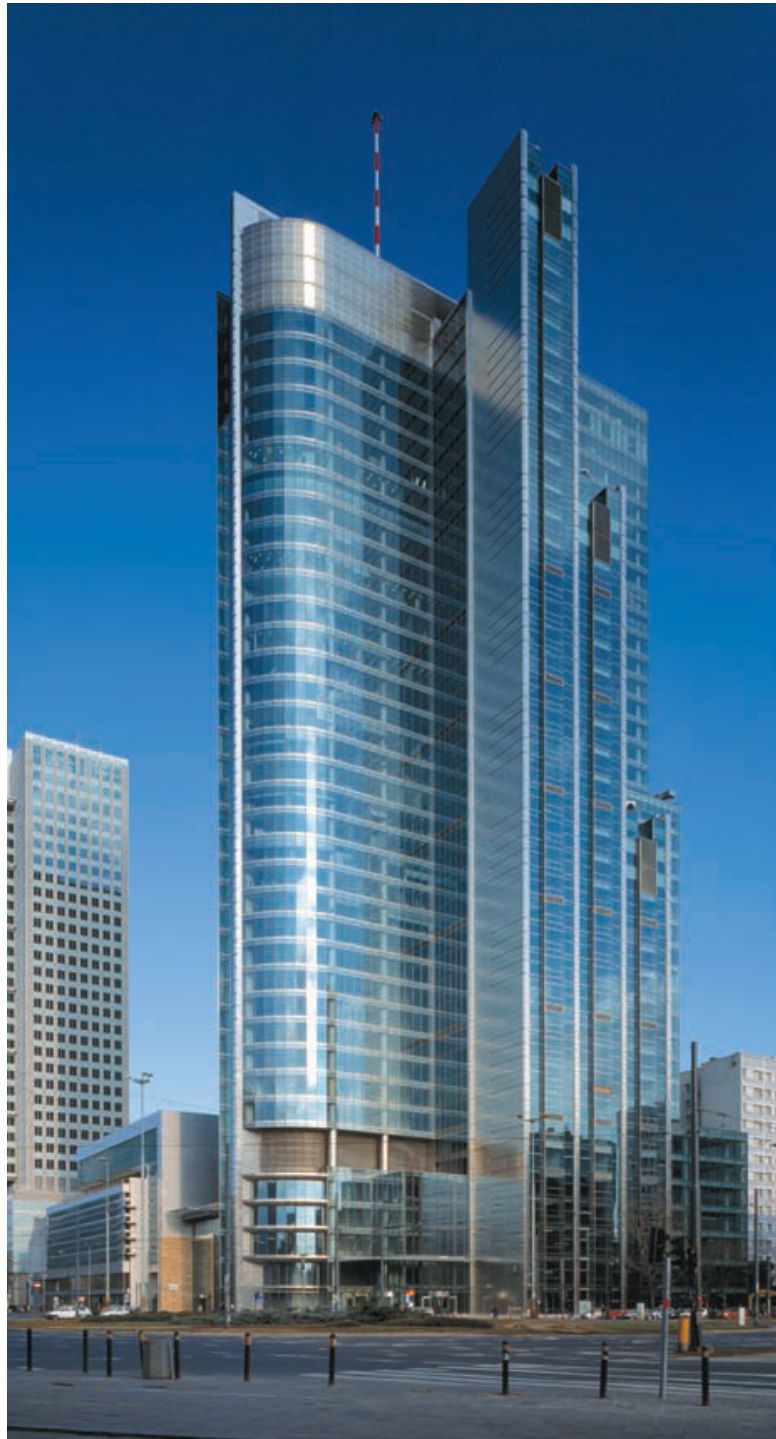
Budynek: Rondo 1 Miasto: Warszawa Deweloper: Hochtief Development Poland
