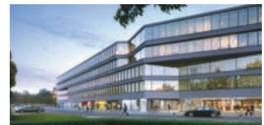
Budynek: Royal Wilanów Miasto: Warszawa Developer: Capital Park
