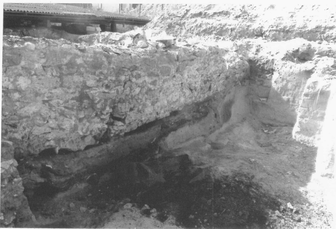
il. 4, Częstochowa, Stary Rynek, ptn ściana płytko fundowanego skrydła ptn dobudowanego do starszego obiektu, na pow. ściany wyróżnia się część licowa z warstwowo układanych brył a niżej swobodnie formowany fundament, pod ścianą warstwy spalinizny po drewnianej konstrukcji, fot. WN 2009r.
