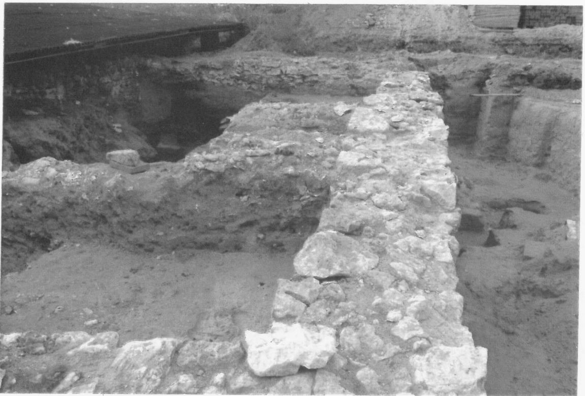
il. 8, Częstochowa, Stary Rynek, odstanięte ściany zamykają skrydło dobudowane do starszego obiektu, liczące powierzchnie plan ściany tworzą średnie i większe nieregularne gładzie tamanego wapienia, a wągłne muru wypełnia gruz zalany zaprawą fot. WN 2009 r.
