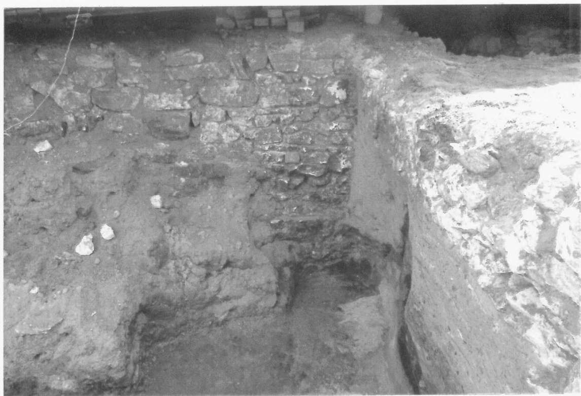
il. 18, Częstochowa, Stary Rynek, wzniesienie obiektu do budowanego do starszego budynku (ściana w głębi) po prawej płytko fundamentowana ściana zachodnia a pod nią przepalona warstwa określająca pozycję wreszcie tu stojącego drewnianego budynku. fot. WN 2009r.
