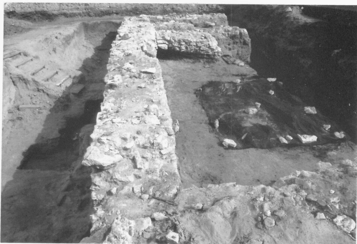
il. 2, Częstochowa, Stary Rynek, płytko fundowane ściany ptn skrydła dobudowanego do starszego obiektu, w koronie muru czytelna struktura z charakterystycznymi bryłami kamienia w lico- wych krawędziach, wnętrze wypełnione gruzem fot. WN 2009 r.
