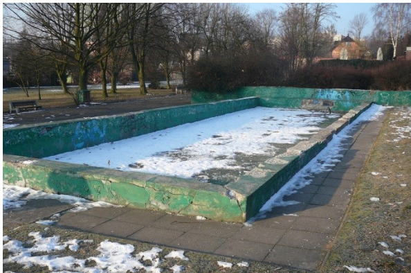
Rysunek 2: Żelbetowa niecka nieczynnego basenu
