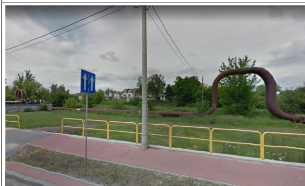
Północna część obszaru objętego planem, położona w sąsiedztwie rzeki Kucelinki z widocznym ciepłociągiem
