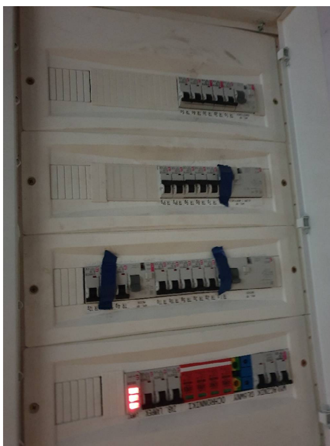
Fot. 8. Tablica rozdzielcza TR do której należy wpiąć wentylatory nawiewne
