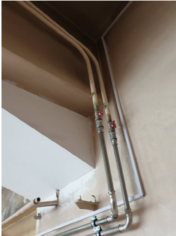
Fot. 13. Widoczne podłączenie nowej instalacji centralnego ogrzewania do starej. Przewody instalacji starej należy domocować do ścian systemowymi obejmami z uszczelką gumową, ponieważ są luźne i nie trzymają się ściany
