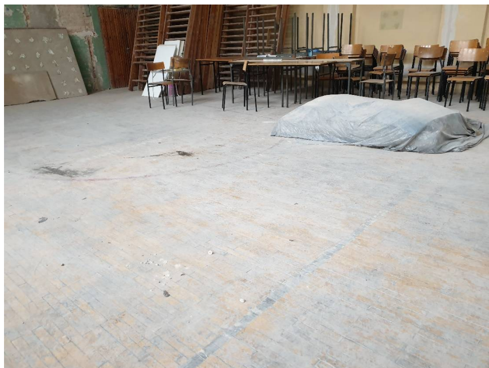
Fot. 12. Parkiet podlegający naprawie (cyklinowaniu)
