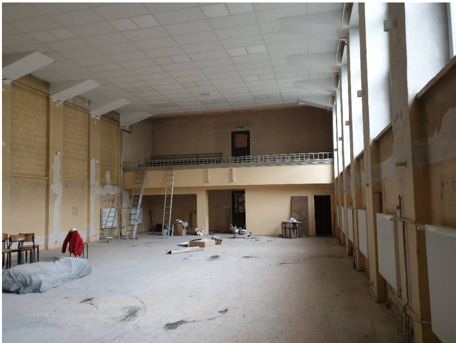
Fot. 6. Widoczna ściana z częścią balkonową. Sufit istniejący należy pozostawić i zabezpieczyć przed zniszczeniem i uszkodzeniami.
