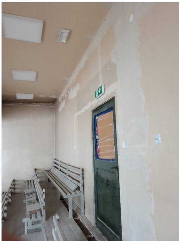
Fot. 14. Widok na balkon. Widać istniejące drzwi nie podlegające wymianie oraz siedziska i obudowa schodków które należy zdemontować i obudowę wykonać nową z płyt OSB gr. 22mm
