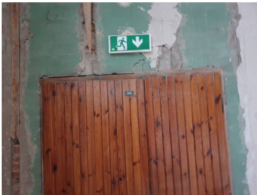
Fot. 3. Drzwi ewakuacyjne, które należy wymienić i zapewnić minimalne światło przejścia 120cm.
