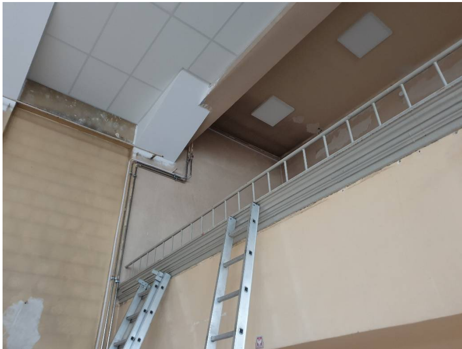
Fot. 5. Widoczny gzyms, który należy pozostawić
