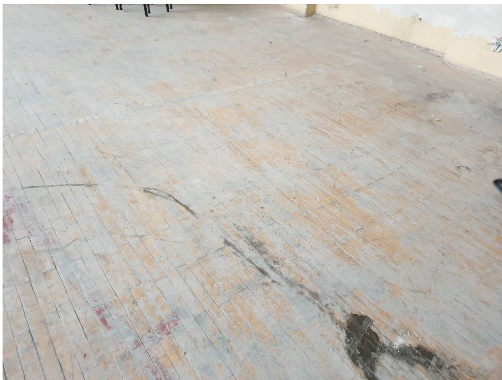
Fot. 11. Parkiet podlegający naprawie (cyklinowaniu)
