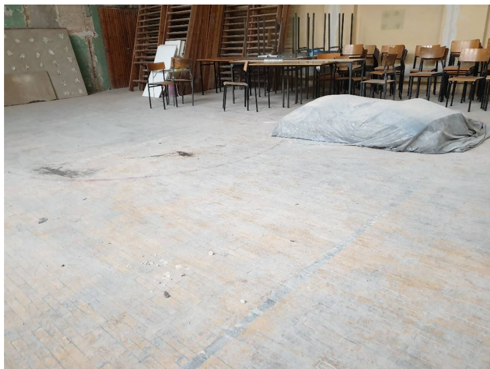
Fot. 12. Parkiet podlegający naprawie (cyklinowaniu)
