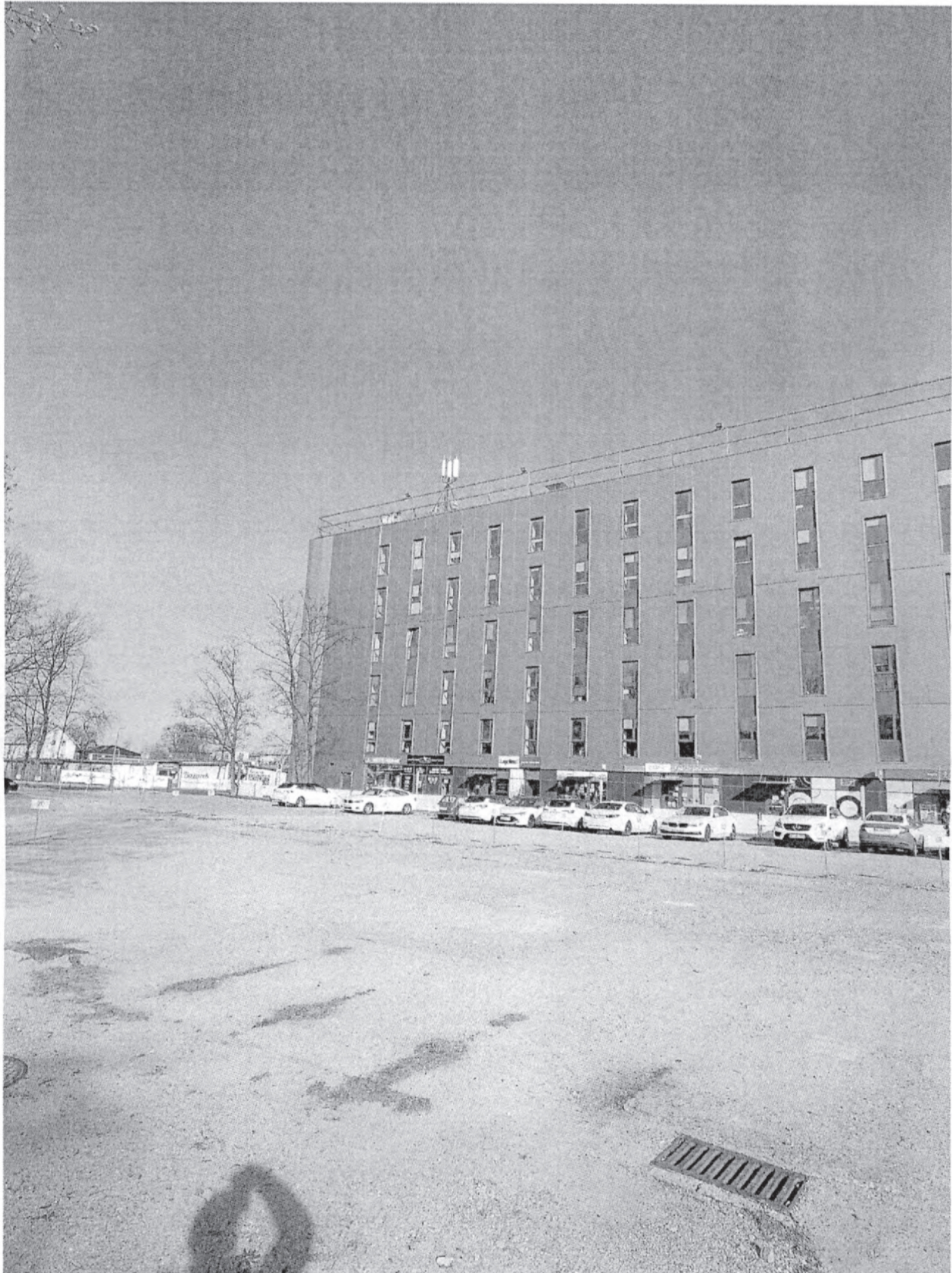
Załącznik nr 3. Instalacja radiokomunikacyjna Orange Polska S.A. 36206N!) CZĘSTOCHOWA_PZU (KCZ_CZESTOCHOWA_PZU) Dokumentacja fotograficzna
