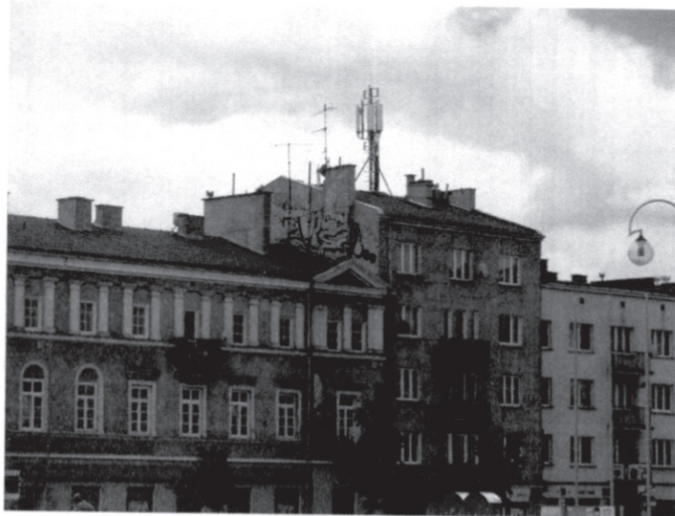
Zal. nr 1: Widok ogólny instalacji radiokomunikacyjnej.
