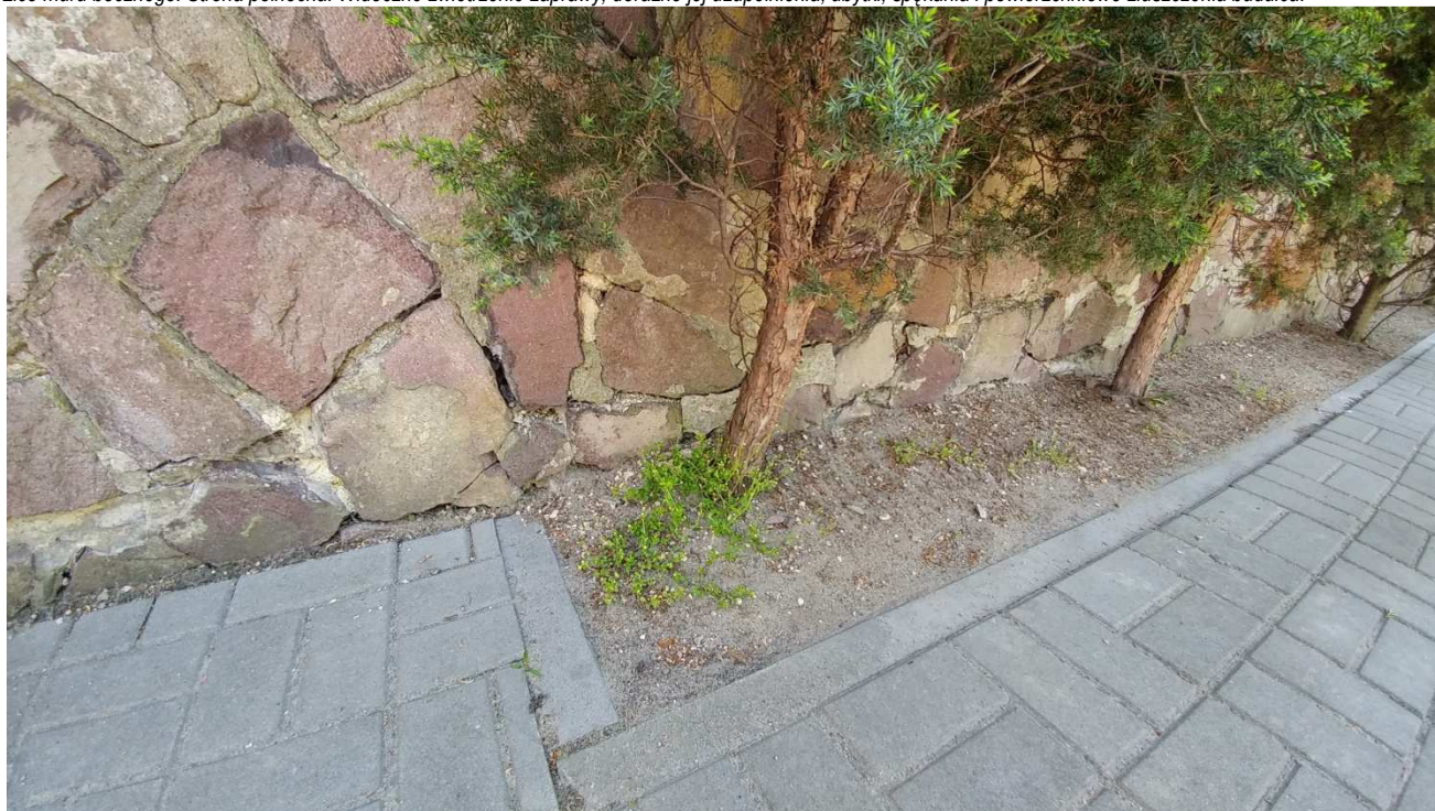
Dalszy fragmentu północnej elewacji ogrodzenia bocznego. Ubytki zaprawy w części przyziemnej i ślady napraw dokonanych w przeszłości.
