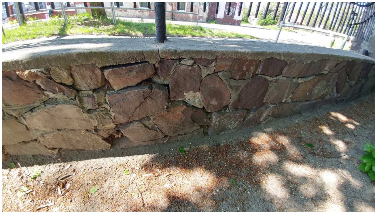
Wewnętrzna strona podmurówki frontowego ogrodzenia – rozsadzony mur. Widoczne próby doraźnych napraw, a także uszkodzenia kamiennego budulca.
