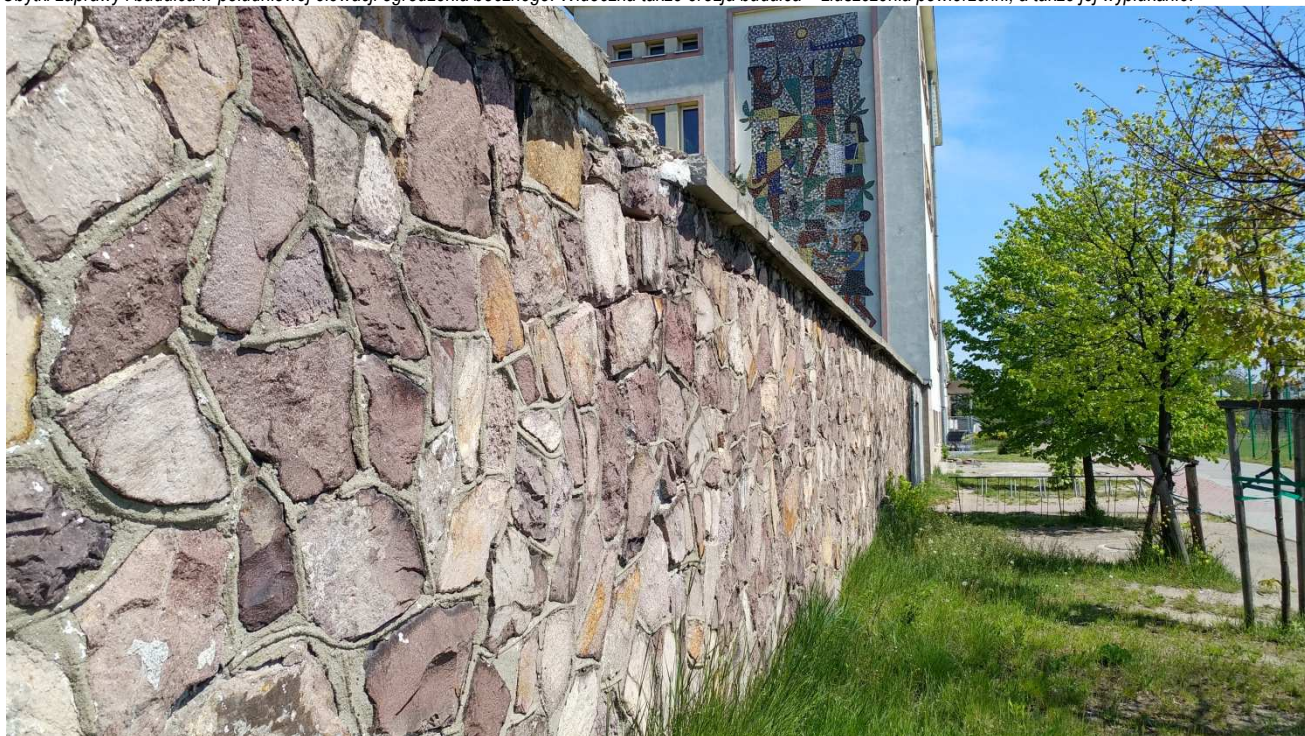
Zwietrzała i wykruszająca się zaprawa ogrodzenia bocznego. Ubytki i spękania nakrywy. Pod nakrywą widoczne pęknięcia i zarysowania świadczące o jej odspojeniu od muru.
