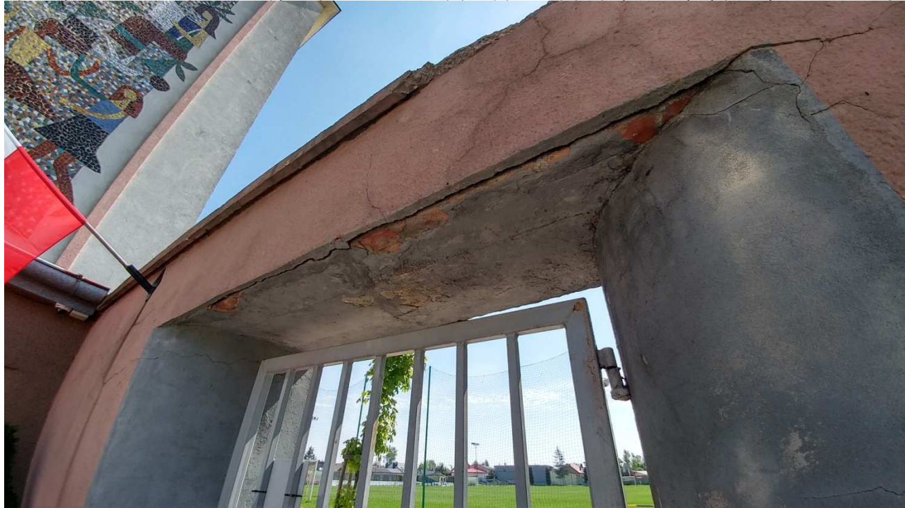
Spękania i odspojenie tynku na nadprożu przejścia pomiędzy terenem szkoły a boiskami sportowymi. Element stanowi zagrożenie bezpieczeństwa.
