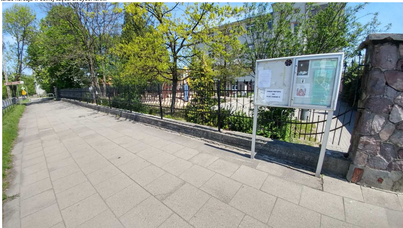
Ogrodzenie frontowe. Podmurówka naprawiana w przeszłości poprzez wykonanie deskowania i zalanie lica zaprawą oraz wykonanie wylewki na górnej powierzchni.
