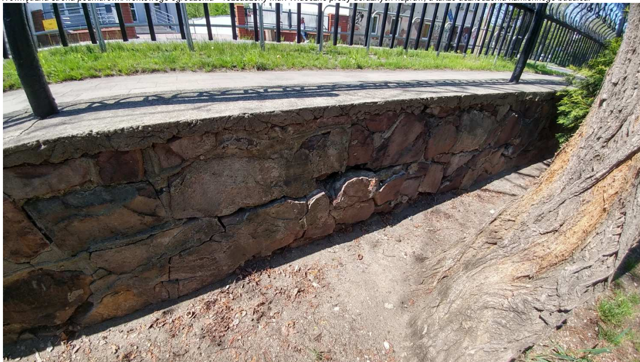
Rozsadzona podmurówka – skutek zawilgocenia muru oraz działania mrozu.
