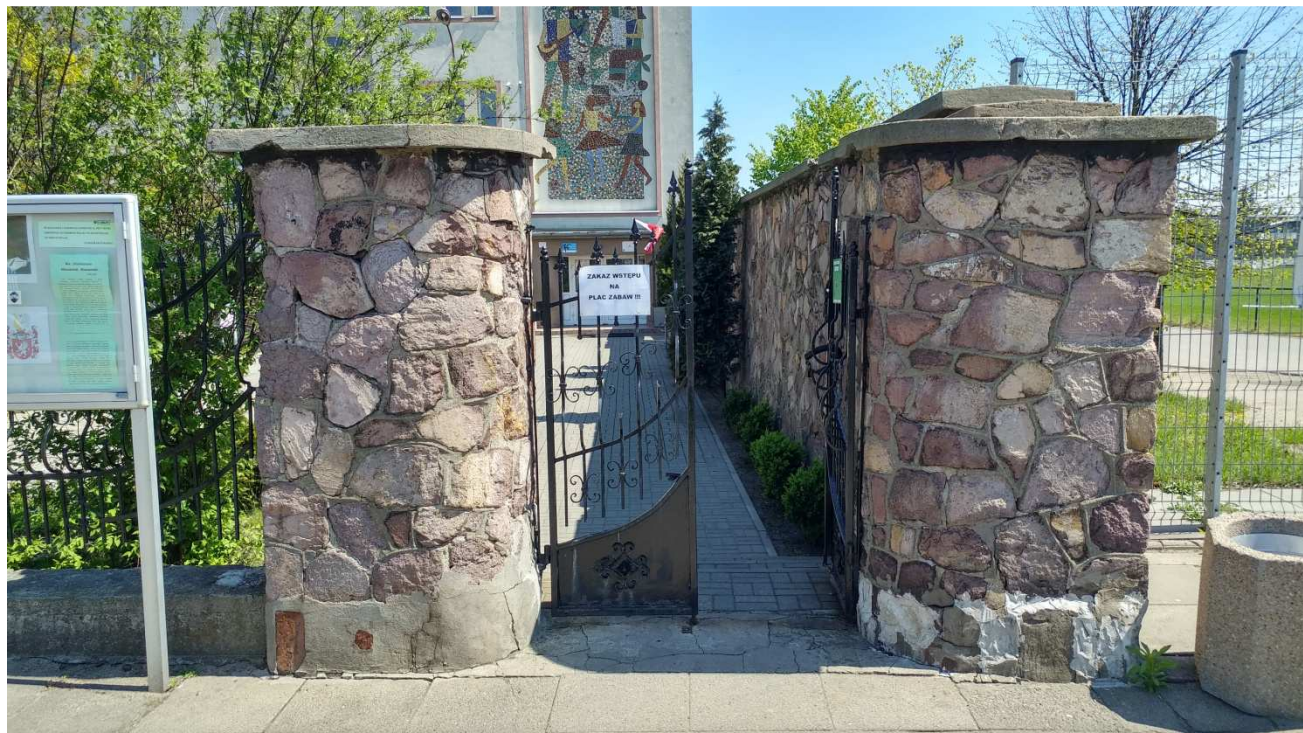
Wejście główne na teren szkoły. Widoczne ślady doraźnych napraw słupków w dolnej części, ubytki zaprawy łączącej materiał kamienny, spękania nakryw. Widoczna także korozja w dolnej części skrzydeł furtki.
