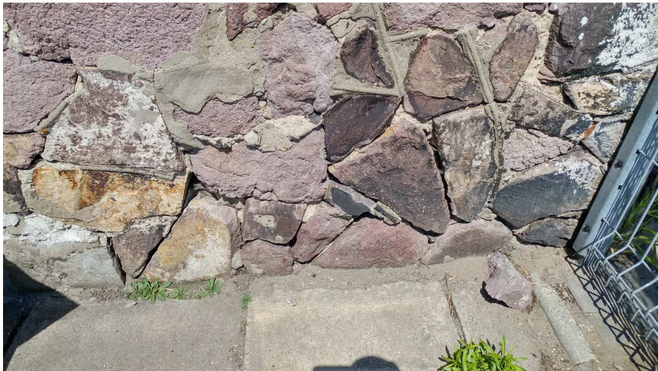
Ubytki zaprawy i budulca w południowej elewacji ogrodzenia bocznego. Widoczna także erozja budulca – złuszczenia powierzchni, a także jej wypłukanie.
