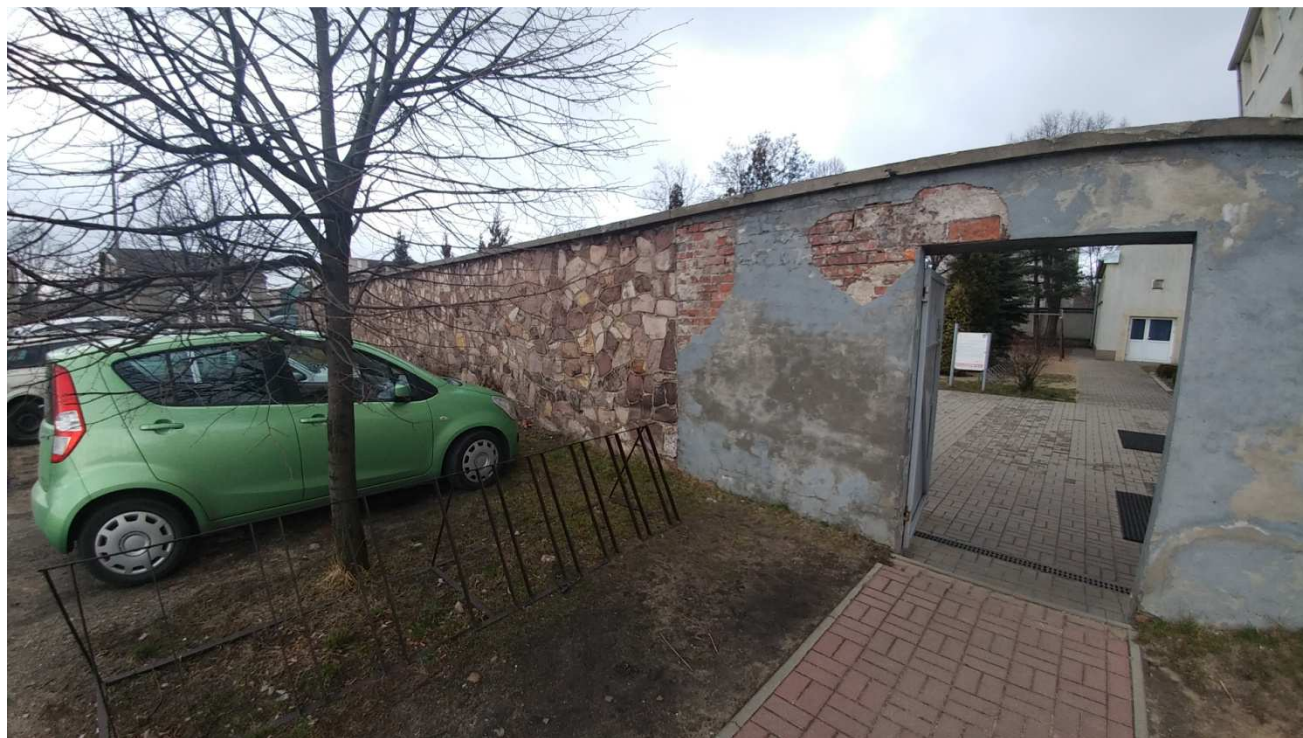
Południowa elewacja muru bocznego. W części ceglanej widoczne ubytki tynku oraz duże powierzchnie zawilgocone. Nakrywa spękana, nosząca ślady doraźnych napraw w przeszłości
