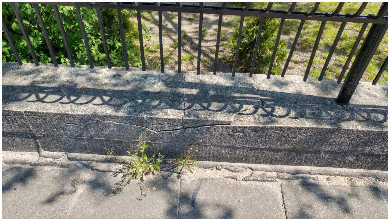
Spękania podmurówki ogrodzenia frontowego od strony pasa drogowego. Przy powierzchni chodnika widoczna linia stanowiąca prawdopodobne pierwotne lico podmurówki.
