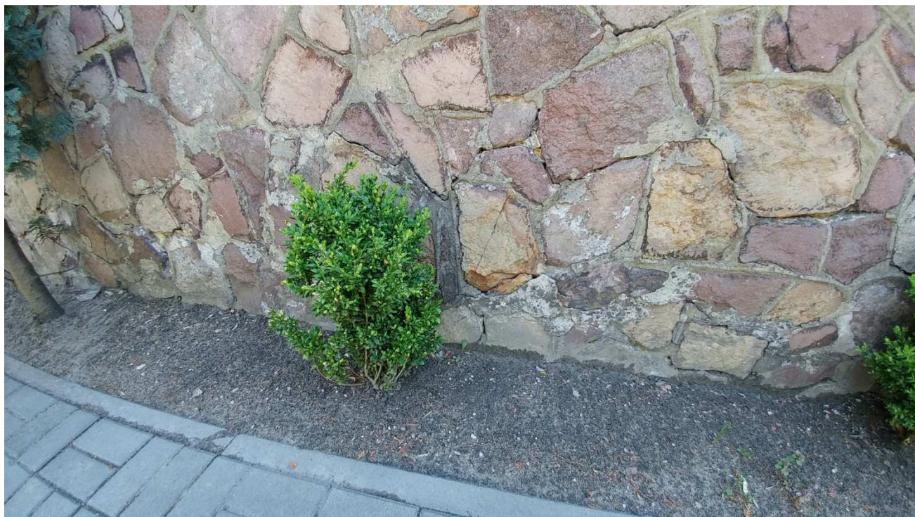
Lico muru bocznego. Strona północna. Widoczne zwiędnięcie zaprawy, doraźne jej uzupełnienia, ubytki, spękania i powierzchniowe złuszczenia budulca.
