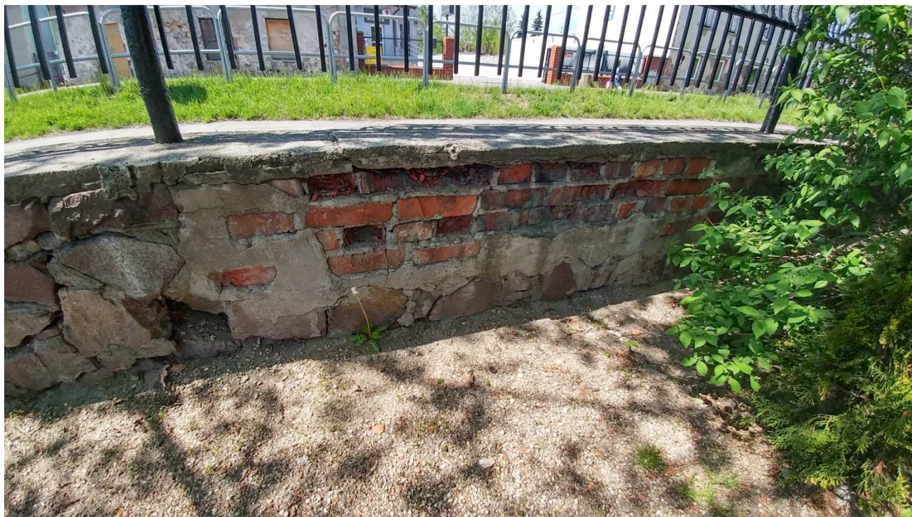
Doraźne naprawy podmurówki w przeszłości. Po lewej stronie widoczny rozsadzony fragment muru.
