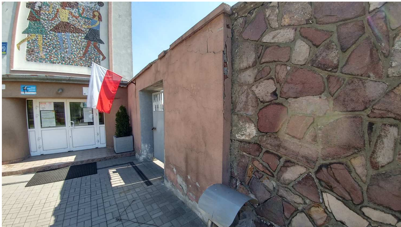
Ceglana część ogrodzenia bocznego. Widoczne spękania tynku, uszkodzenia nakrywy, odspojenie nakrywy na połączeniu z częścią wykonaną z kamienia naturalnego.
