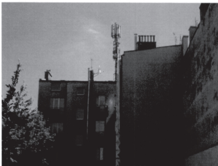
Zal. nr 1: Widok ogólny instalacji radiokomunikacyjnej.
