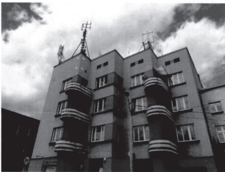
Zał. nr 1: Widok ogólny instalacji radiokomunikacyjnej.
