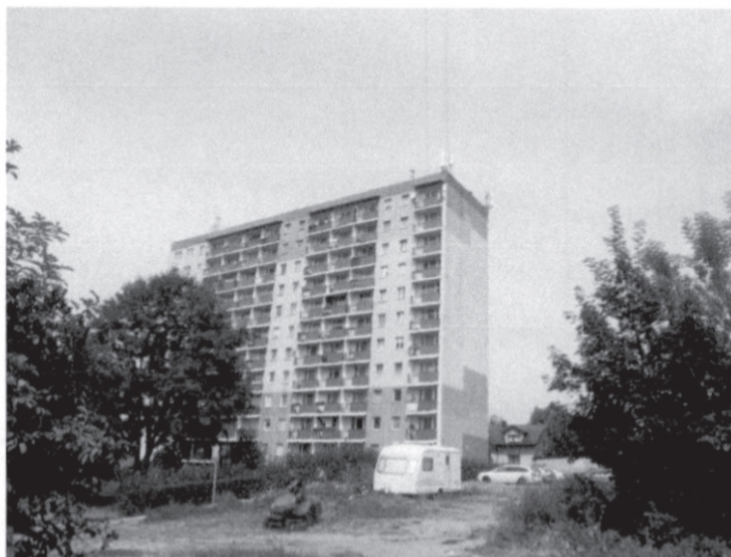
Zal. nr 1: Widok ogólny instalacji radiokomunikacyjnej.
