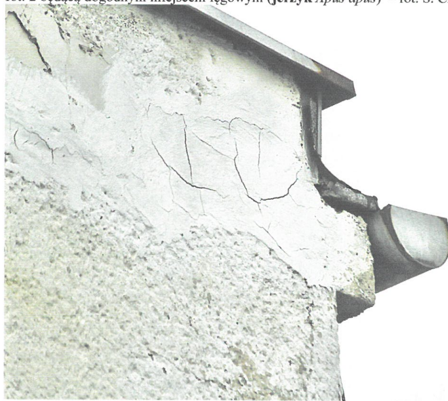
Fot. 5. Częstochowa, ul. Kilińskiego 62, zespół budynków II Liceum Ogólnokształcącego – segment A fragment elewacji południowej. Zbliżenie na szczeliny pod obróbką blacharską dachu oznaczoną na fot. 2 będące dogodnym miejscem lęgowym ( jerzyk Apus apus ) – fot. S. Czyż.
