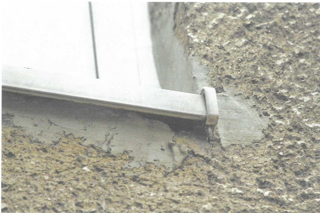
Fot. 27. Częstochowa, Al. Armii Krajowej 68A, zespół budynków Szkoły Podstawowej nr 42 – fragment elewacji wschodniej segmentu A. Zbliżenie na szczelinę pod parapetem okiennym będącą doskonałym miejscem lęgowym dla jerzyków – fot. S. Czyż.
