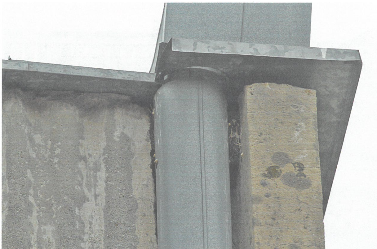
Fot. 14. Częstochowa, ul. Kasztanowa 7/9, zespół budynków Szkoły Podstawowej nr 36 – segment A fragment elewacji północnej. Zbliżenie na szczeliny przy rynnie i pod obróbką blacharską oznaczone na fot. 12. Widoczne stare gniazdo wróbla Passer domesticus , pozostałe szczeliny dogodne do gniazdowania jerzyka Apus apus – fot. S. Czyż
