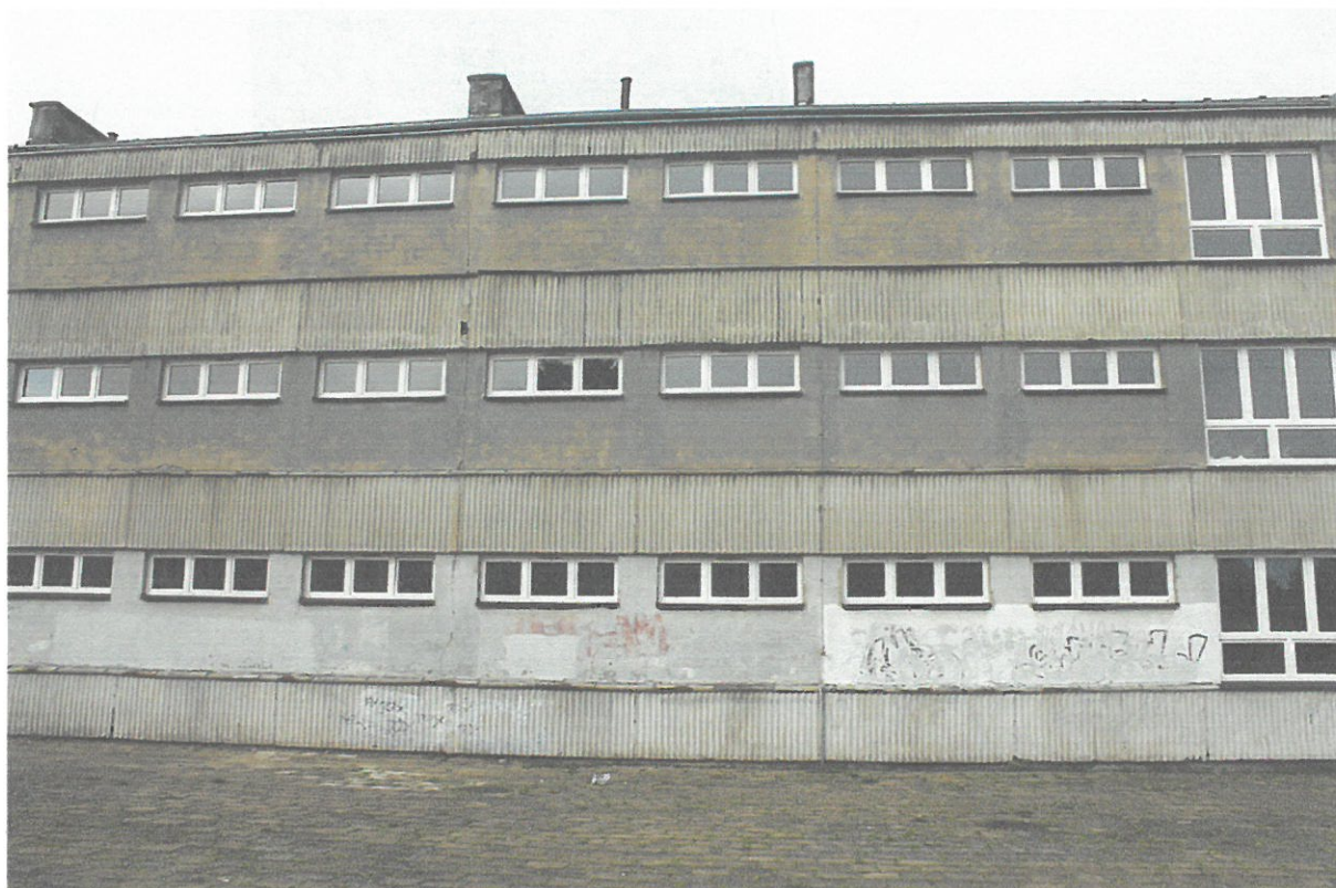
Fot. 16. Częstochowa, ul. Kasztanowa 7/9, zespół budynków Szkoły Podstawowej nr 36 – segment A elewacja wschodnia fragment II. Pod parapetami okiennymi I i II kondygnacji oraz obróbką blacharską występują szczeliny dogodne do założenia gniazda przez jerzyki PATRZ FOT. 3 – fot. S. Czyż.
