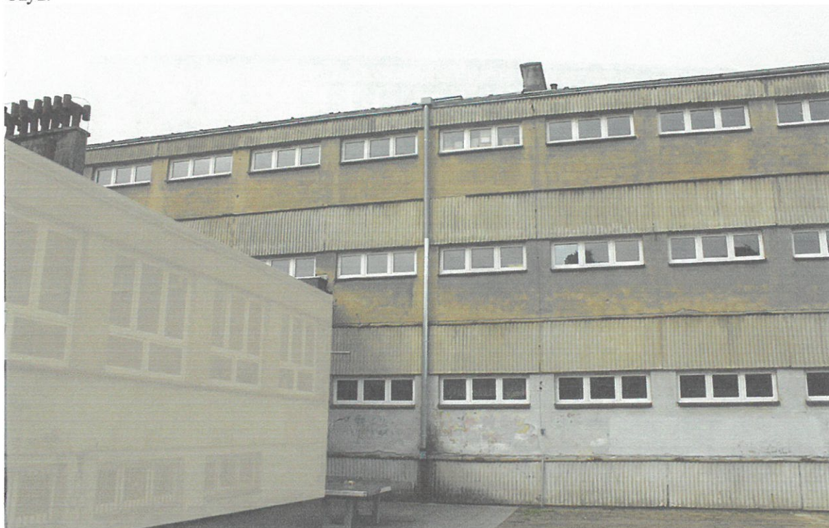
Fot. 17. Częstochowa, ul. Kasztanowa 7/9, zespół budynków Szkoły Podstawowej nr 36 – segment A elewacja wschodnia fragment III. Pod parapetami okiennymi oraz obróbką blacharską I i II kondygnacji występują szczeliny dogodne do założenia gniazda przez jerzyki PATRZ FOT. 3 – fot. S. Czyż.
