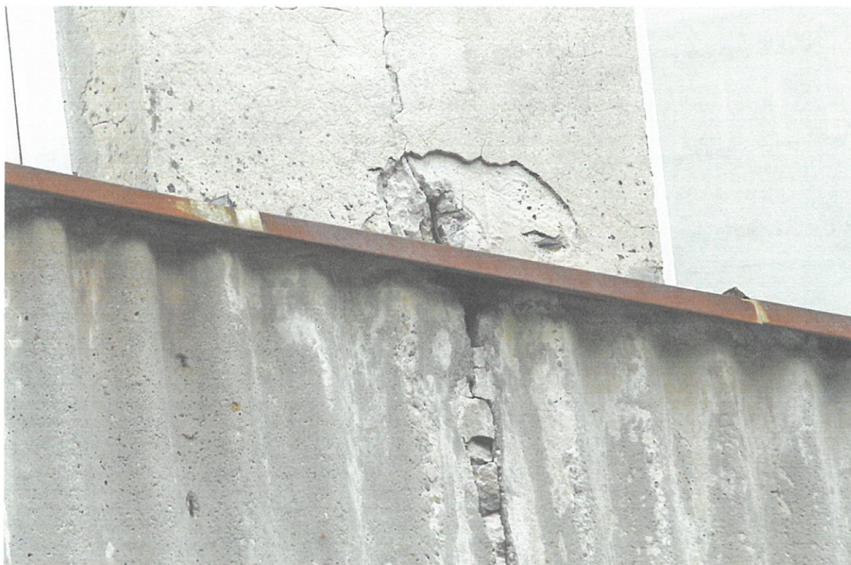
Fot. 4. Częstochowa, ul. Kasztanowa 7/9, zespół budynków Szkoły Podstawowej nr 36 – segment A fragment elewacji zachodniej. Zbliżenie na szczelinę pod obróbką blacharską na łączeniu elementów betonowych zaznaczoną na fot. 2. Szczelina typowa dla gniazda jerzyka Apus apus .
