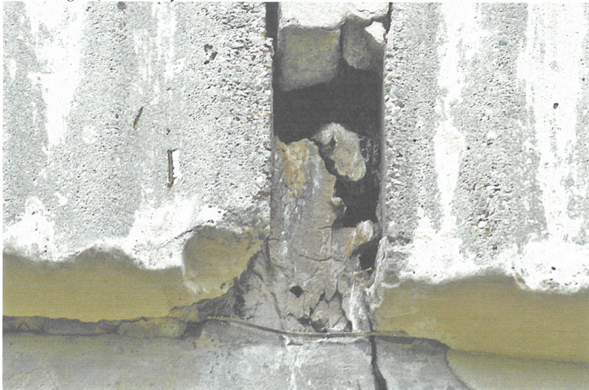
Fot. 7. Częstochowa, ul. Kasztanowa 7/9, zespół budynków Szkoły Podstawowej nr 36 – segment A fragment elewacji zachodniej. Zbliżenie na jedną ze szczelin oznaczonych na fot. 6. Widoczne ślady odchodów świadczą o gniazdowaniu ptaków w tym miejscu – fot. S. Czyż
