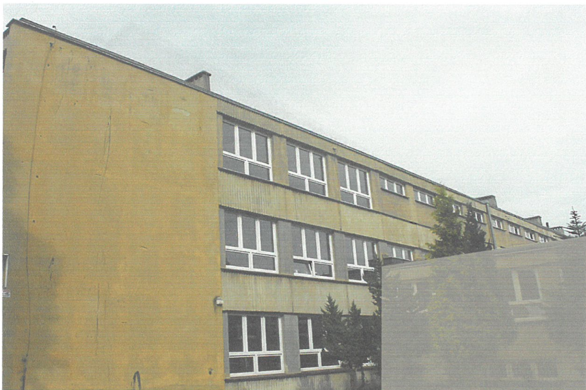
Fot. 29. Częstochowa, ul. Kasztanowa 7/9, zespół budynków Szkoły Podstawowej nr 36 – segment A elewacja wschodnia fragment IV. Pod parapetami okiennymi I i II kondygnacji oraz obróbką blacharską występują szczeliny dogodne do założenia gniazda przez jerzyki PATRZ FOT. 3 – fot. S. Czyż.
