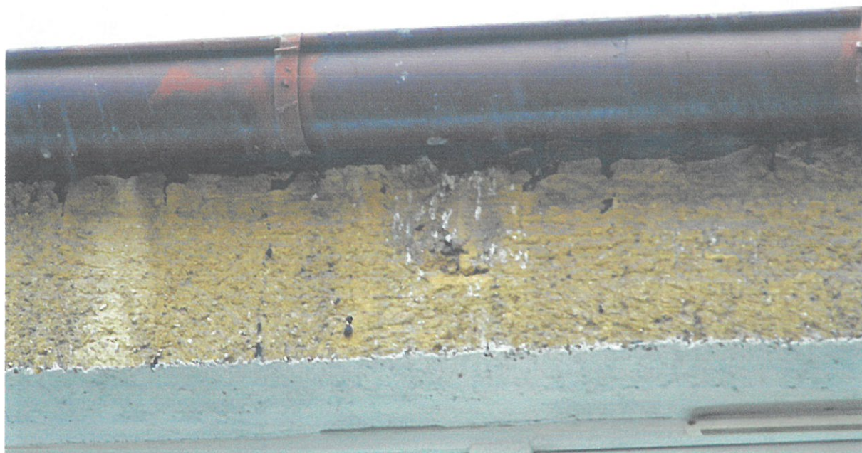
Fot. 6. Częstochowa, Al. Armii Krajowej 68A, zespół budynków Szkoły Podstawowej nr 42 – fragment segmentu A elewacja zachodnia. Zbliżenie na jedną z licznych szczelin występujących na całej długości ściany pod rynną (fot. 2, 3) w których gniazdują jerzyki (widoczne ślady odchodów) – fot. S. Czyż.
