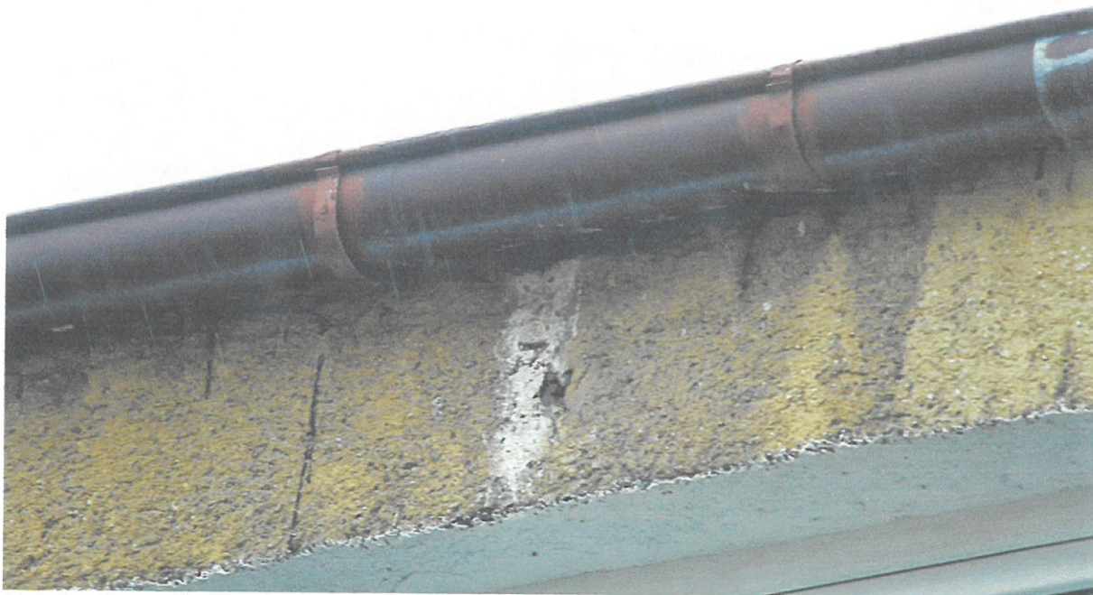
Fot. 8. Częstochowa, Al. Armii Krajowej 68A, zespół budynków Szkoły Podstawowej nr 42 – fragment segmentu A elewacja zachodnia. Zbliżenie na jedną z licznych szczelin występujących na całej długości ściany pod rynną (fot. 2, 3) w których gniazdują jerzyki (widoczne ślady odchodów) – fot. S. Czyż.
