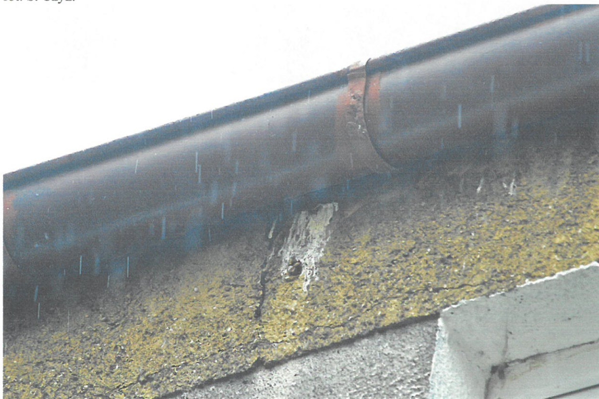
Fot. 11. Częstochowa, Al. Armii Krajowej 68A, zespół budynków Szkoły Podstawowej nr 42 – fragment segmentu B elewacja zachodnia. Zbliżenie na jedną z licznych szczelin występujących na całej długości ściany pod rynną (fot. 4, 5) w których gniazdują jerzyki (widoczne ślady odchodów) – fot. S. Czyż.
