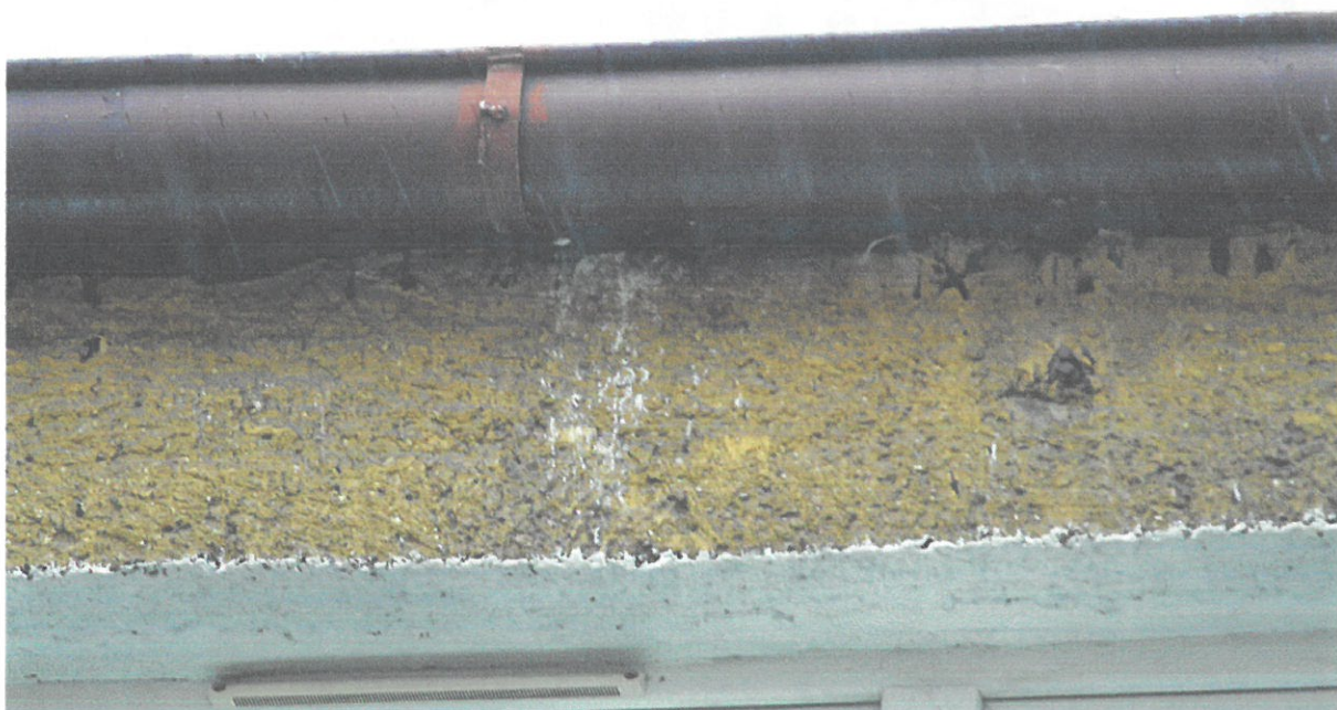
Fot. 7. Częstochowa, Al. Armii Krajowej 68A, zespół budynków Szkoły Podstawowej nr 42 – fragment segmentu A elewacja zachodnia. Zbliżenie na jedną z licznych szczelin występujących na całej długości ściany pod rynną (fot. 2, 3) w których gniazdują jerzyki (widoczne ślady odchodów) – fot. S. Czyż.
