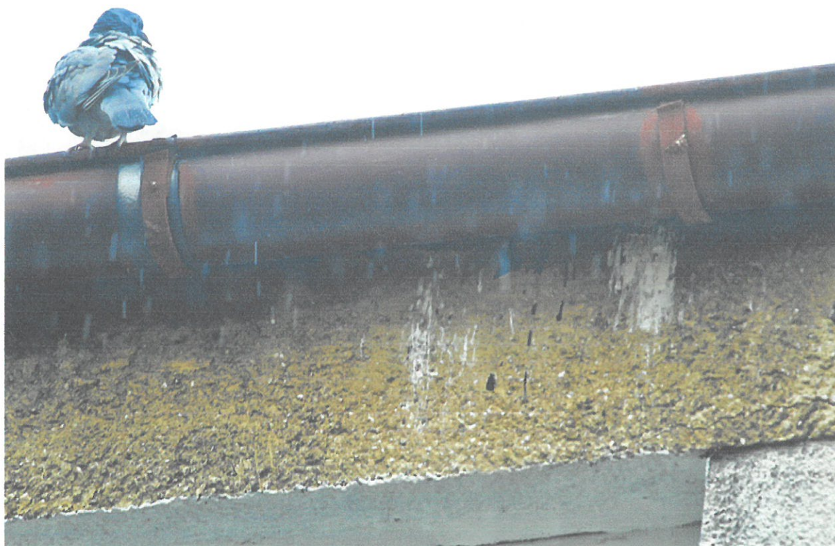
Fot. 10. Częstochowa, Al. Armii Krajowej 68A, zespół budynków Szkoły Podstawowej nr 42 – fragment segmentu B elewacja zachodnia. Zbliżenie na jedną z licznych szczelin występujących na całej długości ściany pod rynną (fot. 4, 5) w których gniazdują jerzyki (widoczne ślady odchodów) – fot. S. Czyż.
